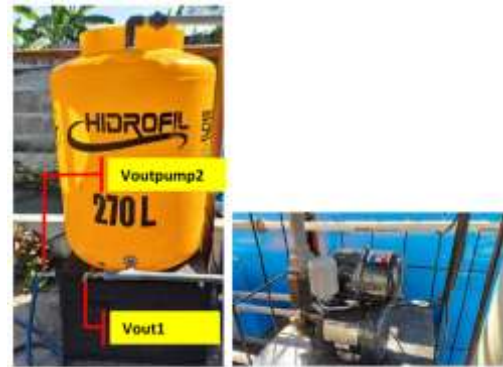
Gambar 7. (a) Bak penampung akhir 270 liter dengan kran Vout1 dan Voutpump2 serta (b) pompa outlet untuk penyiraman
